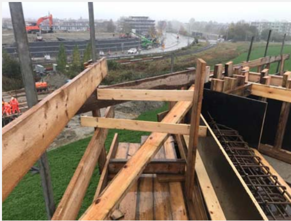
FOTO 3 – LEUNINGWERK NIET DOORVALVEILIG (ONDEUGDELIJK)
