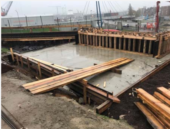
FOTO 3 – LEUNINGWERK NIET DOORVALVEILIG (ONDEUGDELIJK)
