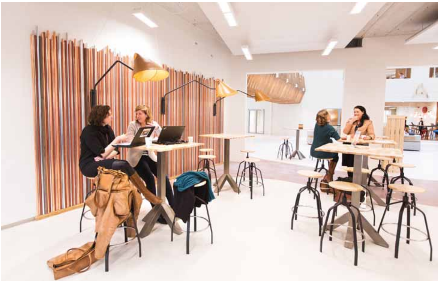
Circulariteit in beeld: een van de wanden in deze ontmoetingsruimte voor medewerkers is bekleed met buizen die vrijkwamen bij de renovatie.
